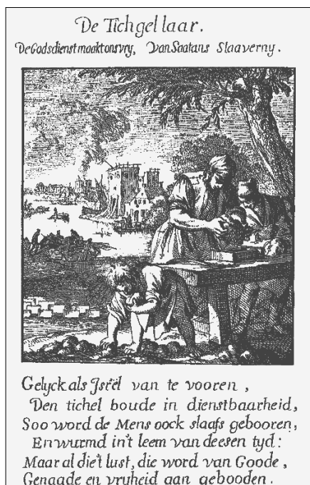
Fig. 7. De vormer slaat de klei in de vormbak. Op de achtergrond een brandende steenoven (Jan Luyken, afbeelding van 'De Tichelaar', uit Spieghel van het menselyk bedrijf, 1694).
