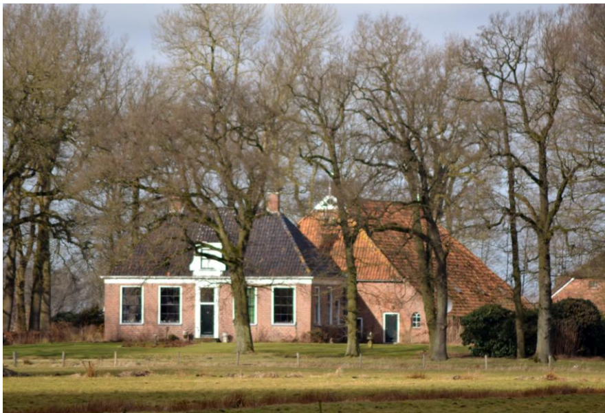
De Waalborg na restauratie van het dak van de schuur in 2014. (foto Lia Snoek)
