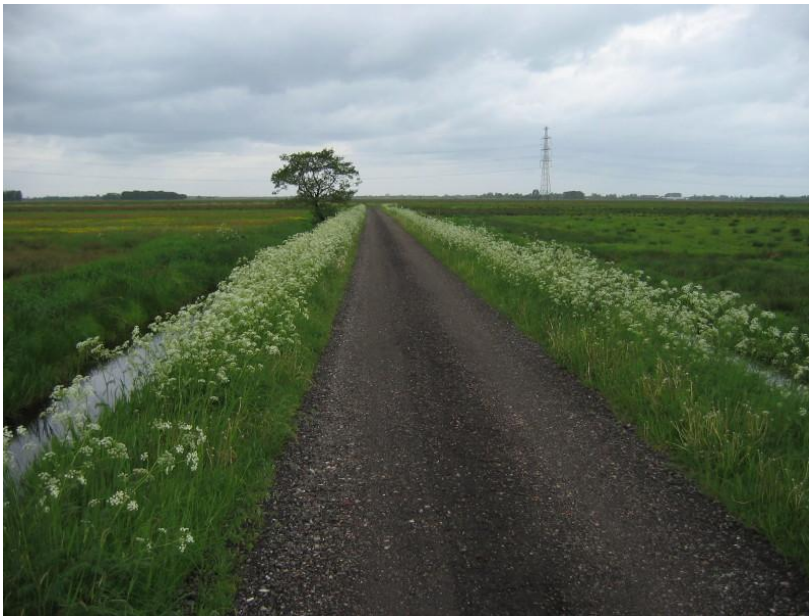
De Onlandse Dijk vóór de herinrichting van de Onlanden. (foto Wim van Boekel)
